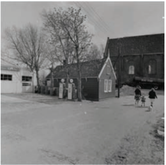
Links de oude schuur, rechts het voormalig brandweershuisje, nu woning Achterlaan 14
